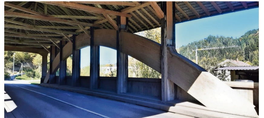
Dörflibrücke mit typischem Holzbogenträger
